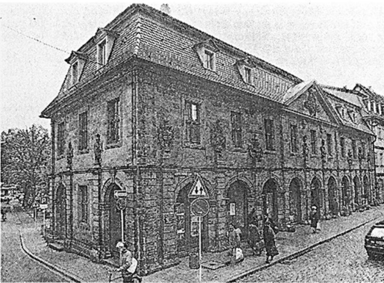
Zwei Geschäfte teilen sich künftig die Räumlichkeiten des ehemaligen Fremdenverkehrsamtes in der Hauptwachstraße.
